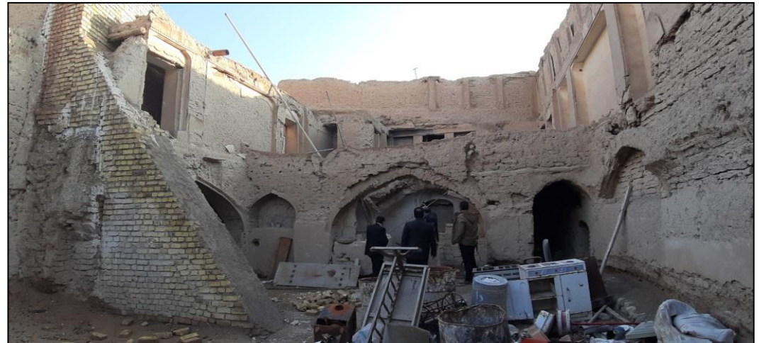
تصویر شماره ۱۶- نمای حیاط خدمه اندرونی
