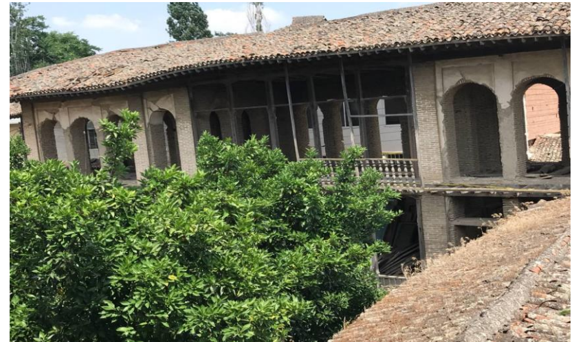
تصویر شماره ۶ نمای خارجی ساختمان شرقی
