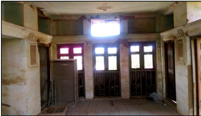
تصویر شماره ۳- بخشی از فضای داخلی ساختمان غربی
