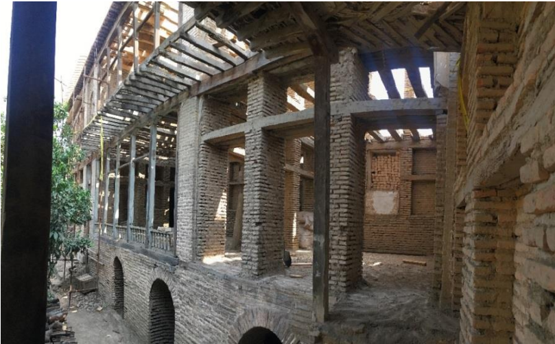
تصویر شماره ۷- نمای خارجی ساختمان شرقی
