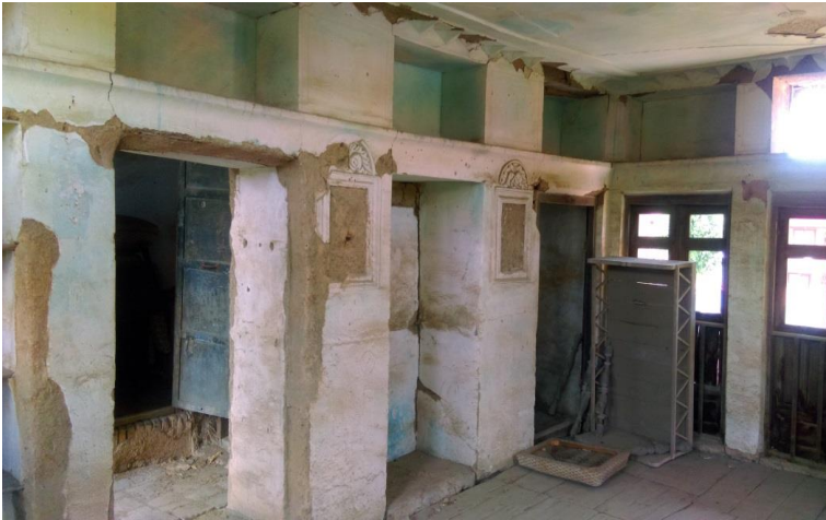
تصویر شماره ۲- بخشی از فضای داخلی ساختمان غربی
