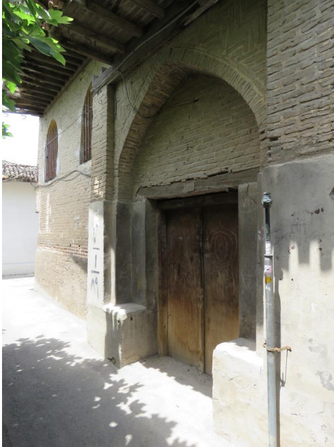
تصویر شماره ۵- آجرکاری سردر
